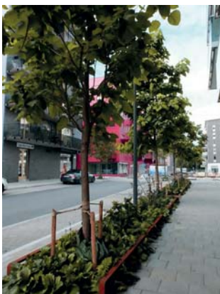
Abb. 17: Gezielte Versickerung von Regenabflüssen in den Pflanzgruben der Straßenbäume in Stockholm. Wichtige Elemente sind dabei grob gebrochener Schotter mit Oberboden gemischt sowie ein Be- und Entlüftungsschacht, der ebenfalls zur Bewässerung dient.
