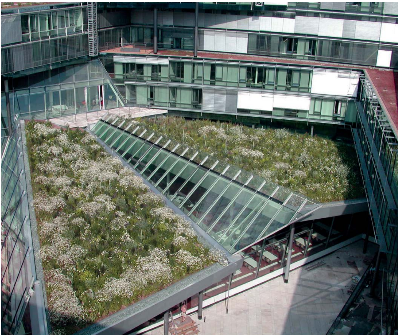
Abb. 18: Intensive Dachbegrünung auf dem Dach der Cafeteria eines Verwaltungsgebäudes. Die Dachbegrünung nimmt das anfallende Regenwasser auf, verdunstet es nach und nach und sorgt somit für ein ausgeglichenes Mikroklima im Innenhof.
