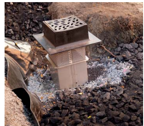
Abb. 17: Gezielte Versickerung von Regenabflüssen in den Pflanzgruben der Straßenbäume in Stockholm. Wichtige Elemente sind dabei grob gebrochener Schotter mit Oberboden gemischt sowie ein Be- und Entlüftungsschacht, der ebenfalls zur Bewässerung dient.
