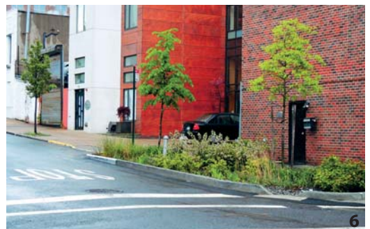
Abb. 12: Verschiedene Anpassungsmaßnahmen für den Neubau und den Bestand (von links nach rechts): Entsiegelung und Begrünung von Vorgärten (1), nachträgliche Versickerungsmulde (2), temporärer Rückhalt von überschüssigem Wasser bei Starkregen auf einem Schulhof (3), Wasserinstallation (4), nachträglich begrüntes Hoteldach (5), nachträgliche Versickerungsflächen in einer Straße (6)
