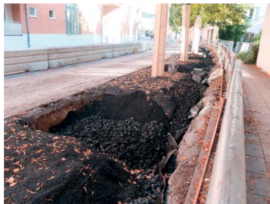
Abb. 17: Gezielte Versickerung von Regenabflüssen in den Pflanzgruben der Straßenbäume in Stockholm. Wichtige Elemente sind dabei grob gebrochener Schotter mit Oberboden gemischt sowie ein Be- und Entlüftungsschacht, der ebenfalls zur Bewässerung dient.
